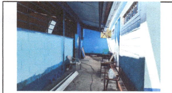
Foto 6: Pintura en muros exteriores e interiores
