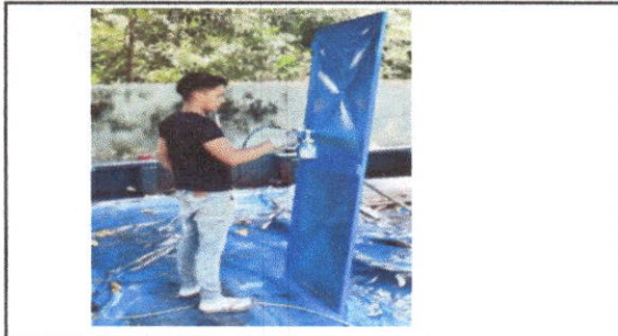
Foto 3: Sustitución de puerta
